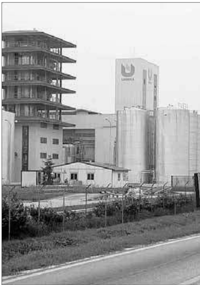
All'Unigrà procedono i lavori per la costruzione della centrale
