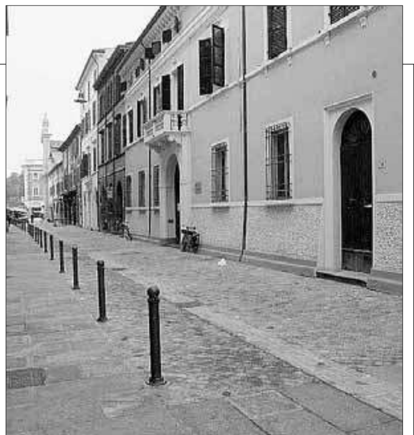
Corso Matteotti Da qui partiranno i lavori per posizionare nuovi cavi di fibra ottica che consentiranno il collegamento delle nuove telecamere
